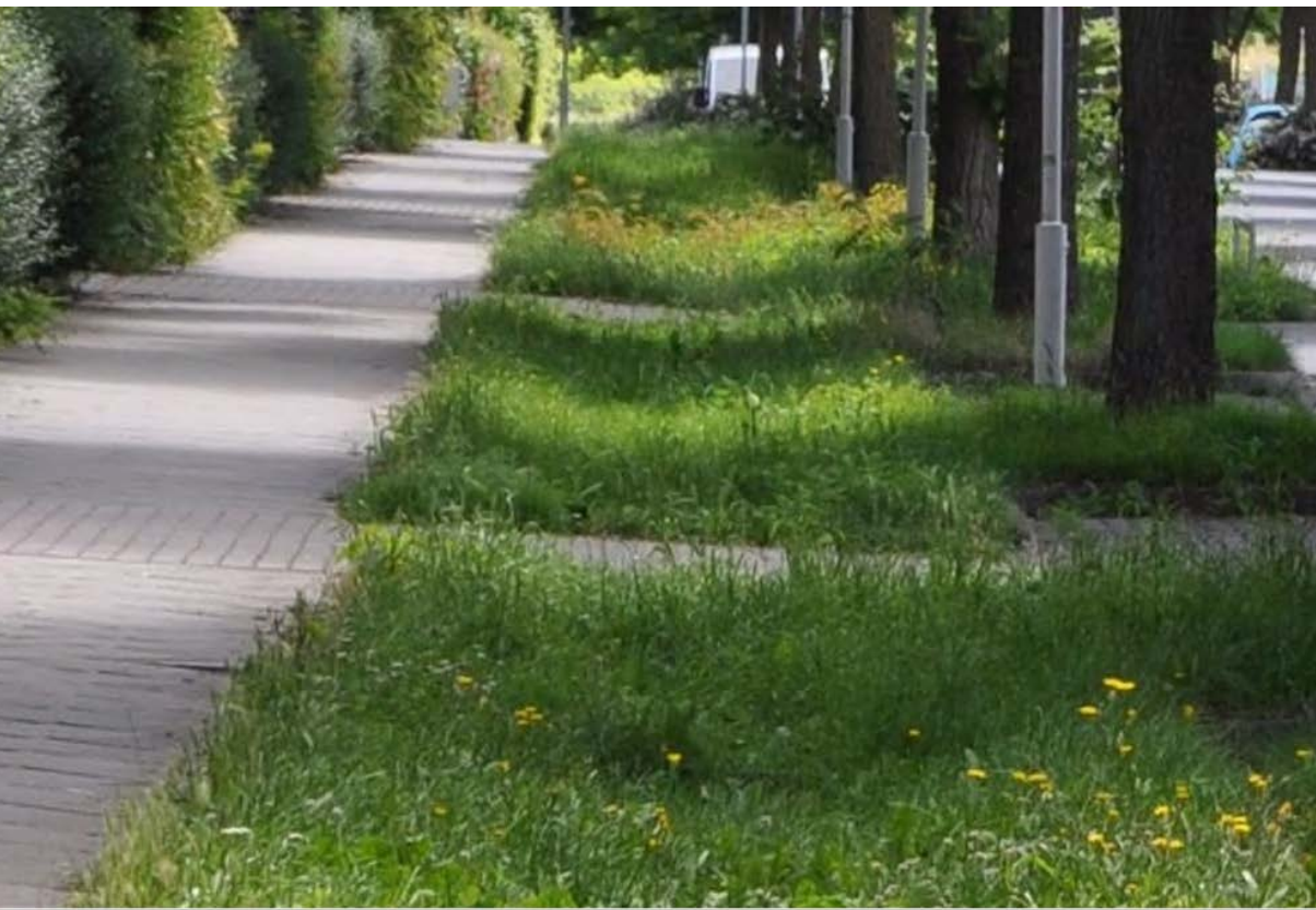
Referenz Kronsberg Hannover Straßenentwässerung mit Mulde
