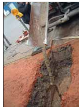
Verfüllung mit Flüssigboden
