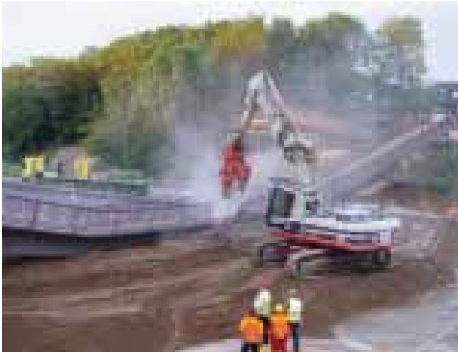
Brückenniederlegung zur Verbreiterung der A3
