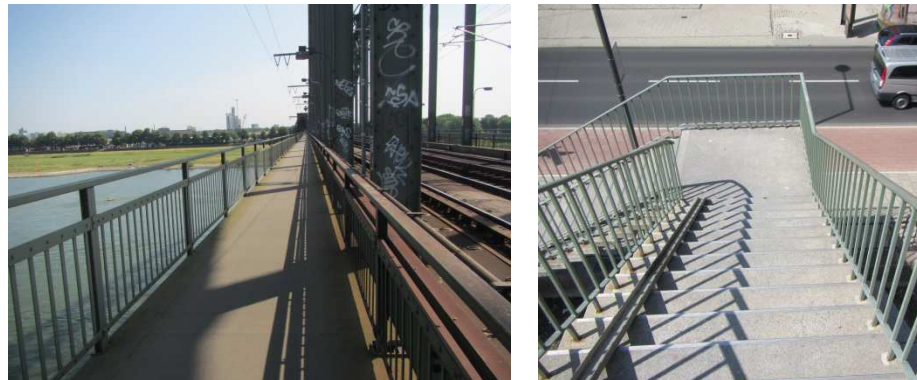
Abbildung 6-17: Südlicher Steg und Treppe mit Schieberillen an der Südbrücke
