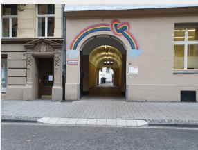
Rampenbord bei Überfahrten für hohe Verkehrslast
