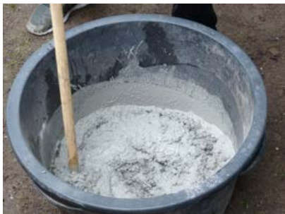
Abbildung 17: Anrühren des Estriches
