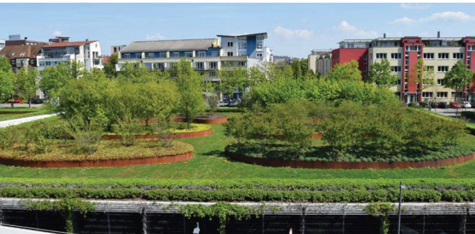
Abbildung 3: Intensive Dachbegrünung (Dachgarten- und Tiefgaragenbegrünungen)
