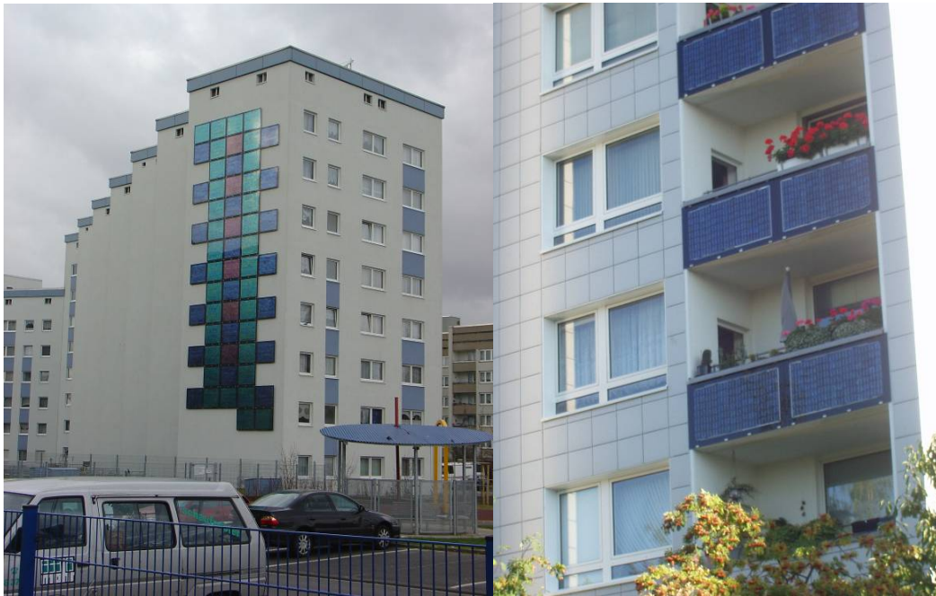
Abbildung 2: Solarmodule als Gebäudefassade; (Solarsiedlung Köln-Bocklemünd, ASG, Antoniter Siedlungsgesellschaft)
