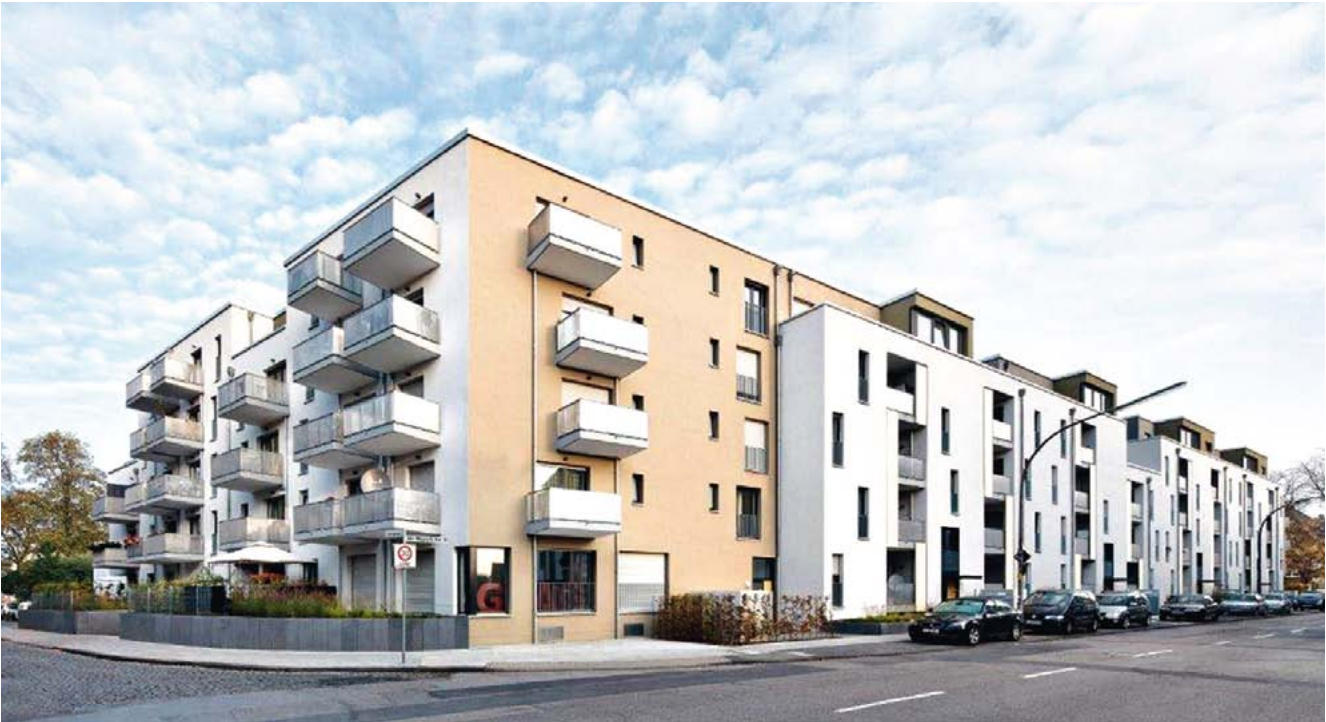
Geförderte Mietwohnungen in Köln-Buchheim (Carlswerkquartier)
