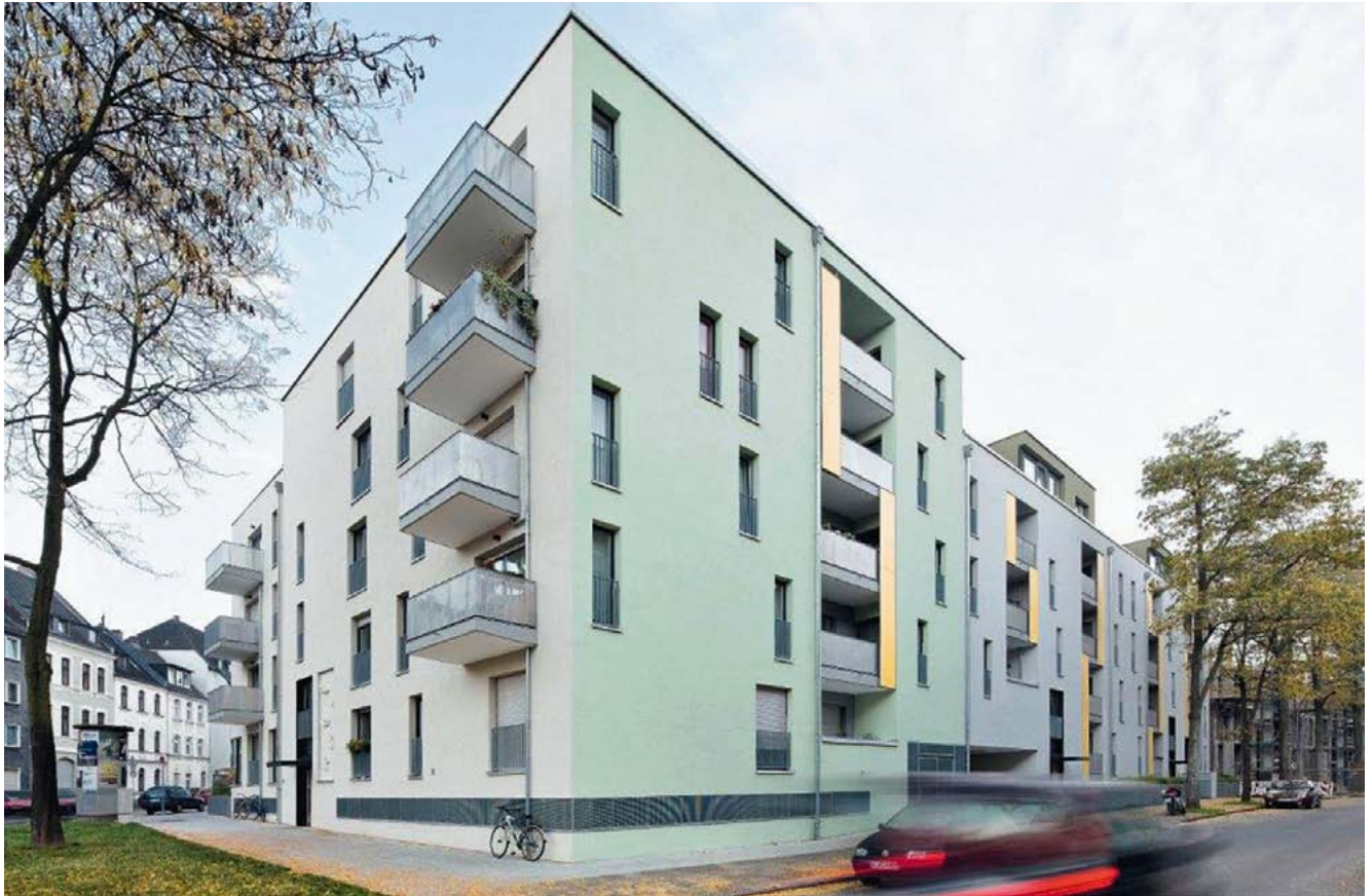
Anlage des geförderten Mietwohnungsbaus in Köln-Buchheim: Auch ein Zuhause für eine Wohngemeinschaft von an Demenz erkrankten Menschen
