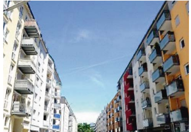
Wer gegen die neue Wohnraumschutzsatzung der Stadt Köln verstößt, muss mit Bußgeldern bis zu 50 000 Euro rechnen. Foto: dpa
