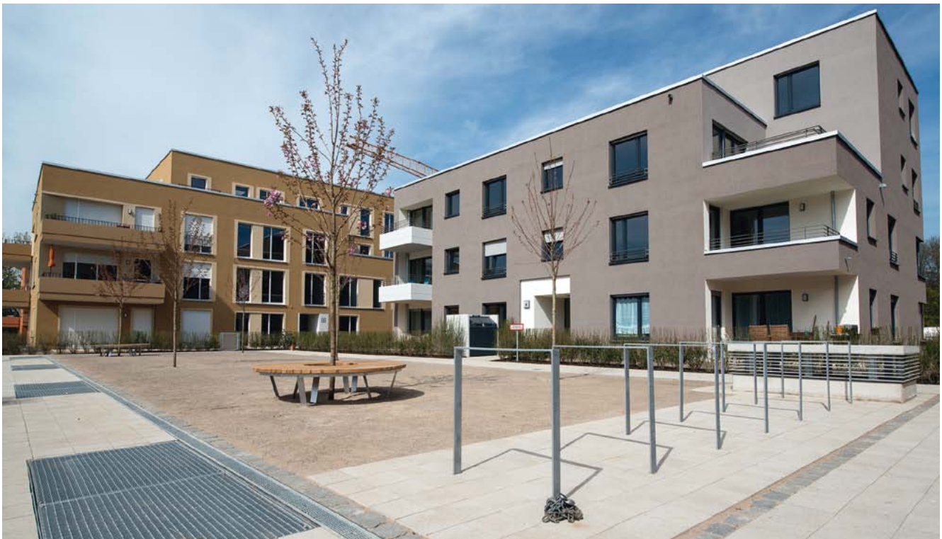
Neubaumaßnahme Waldbadviertel in Köln-Ostheim
