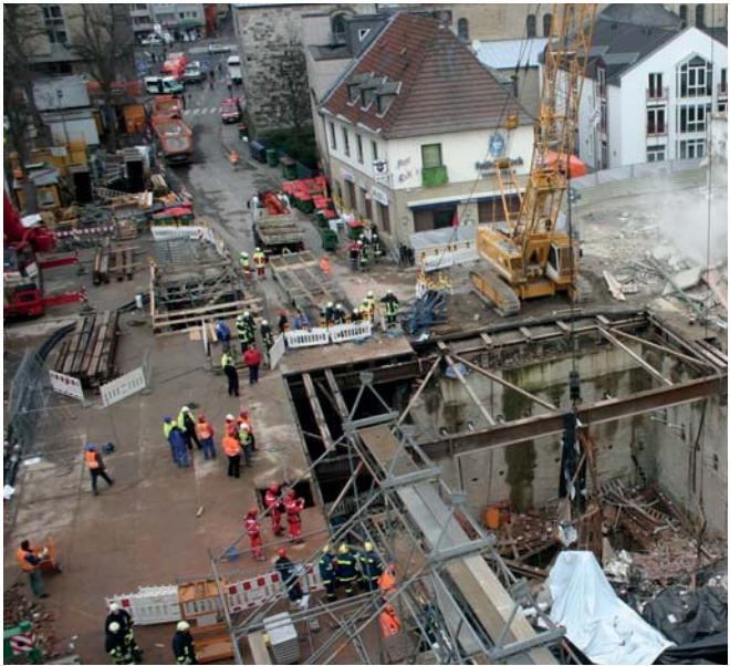
Vermutlich im Zusammenhang mit Arbeiten an der unterirdischen Nord-Süd Stadtbahn sackte der Boden des Historischen Archivs und zweier Wohnhäuser am 3. März 2009, 13:58 Uhr, ab. Wände, Gebäudeteile, Autos und Straßenteile rutschten innerhalb weniger Sekunden in einen mehr als 20 Meter tiefen Krater und türmten sich zu einem 10 Meter hohen Schuttberg.
