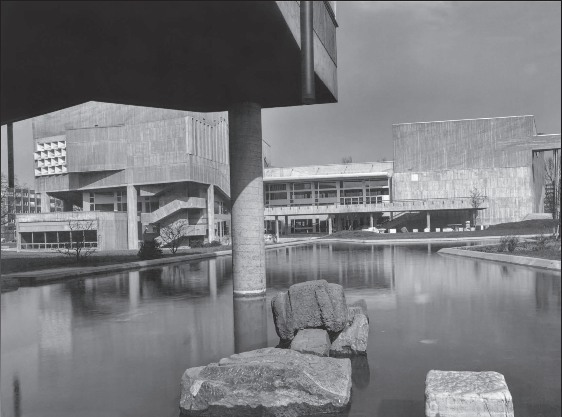
Hörsaalgebäude der Universität zu Köln, Architekt: Rolf Gutbrod, Freiraumgestaltung: Gottfried Kühn, 1968
