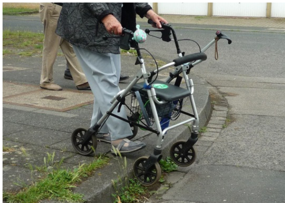
Abbildung 3: Fehlende Bordsteinabsenkung
