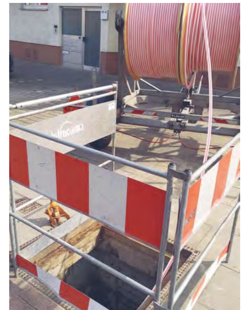
Zur Erweiterung des Fernmeldesondernetzes müssen stellenweise weiträumige Erdarbeiten durchgeführt werden. Insgesamt verlaufen in Köln fast 200 Kilometer Kabel unterirdisch.
