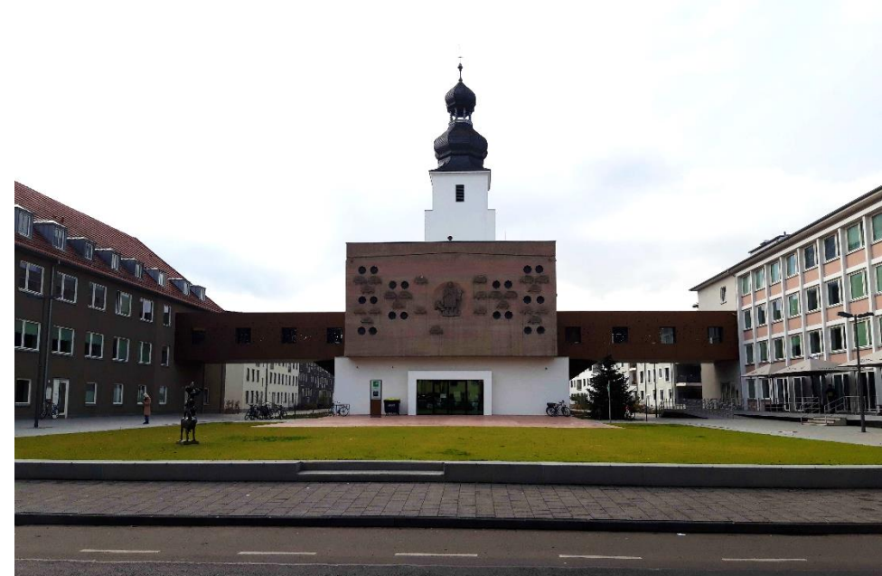
Nach dem Bau im Dezember 2020
