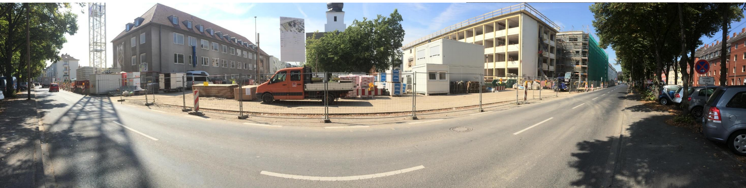
Panorama der Baustelle Elisabeth-von-Mumm-Platz (im August 2018)
