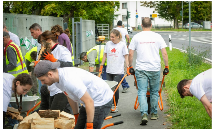
Bau der Insektenmauer
