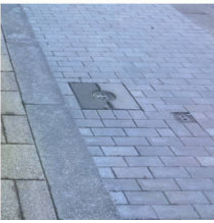
H1.3.2 Anordnung und Einbau (technischen) Elementen im Gehwegpflasterbelag - Standard für N
