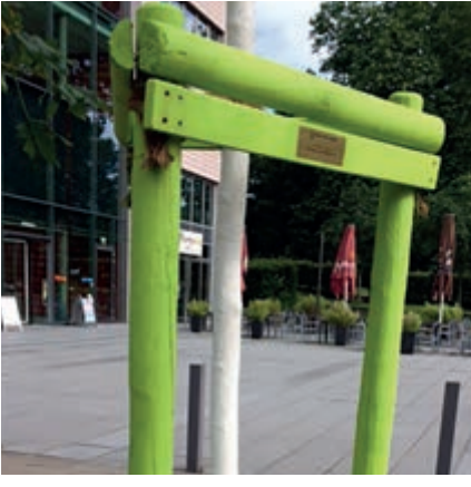
H4.2.3 Stammschutz temporär für N S
