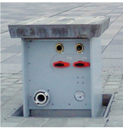
H5.1.3 Technischelement unterflur - Standard
