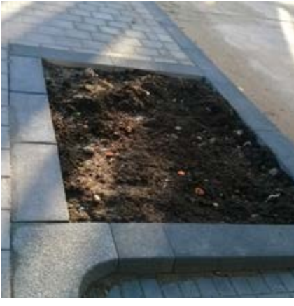
H4.1.4 Baumfeld mit angrenzenden Parkflächen - Standard
