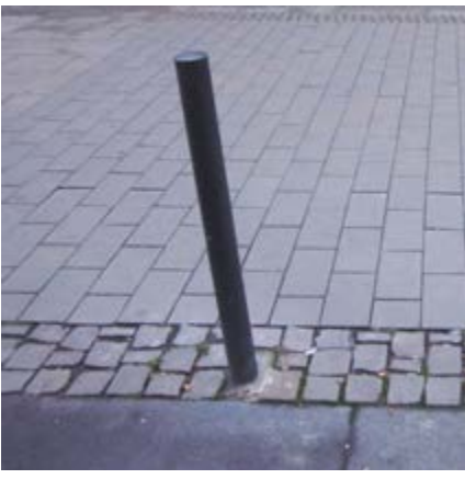
H1.3.1 Anordnung und Einbau von Mobiliar im Kleinpflasterstreifen - Standard
