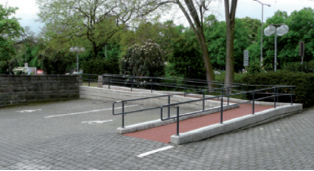
Neu geschaffene Behinderten-Parkplätze mit Rampe am Museum für Ostasiatische Kunst
