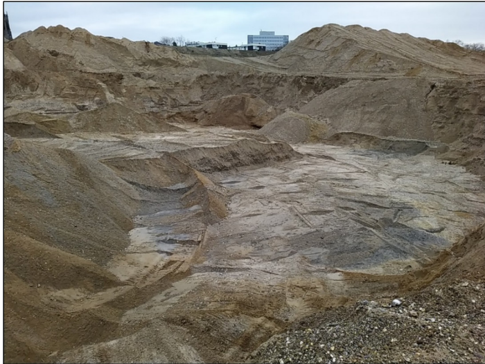
Ölhaltiger Boden (dunkle Verfärbungen)
