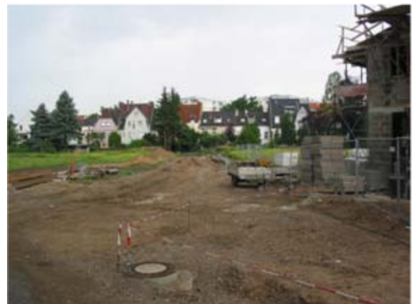
Blick in das Baugebiet
