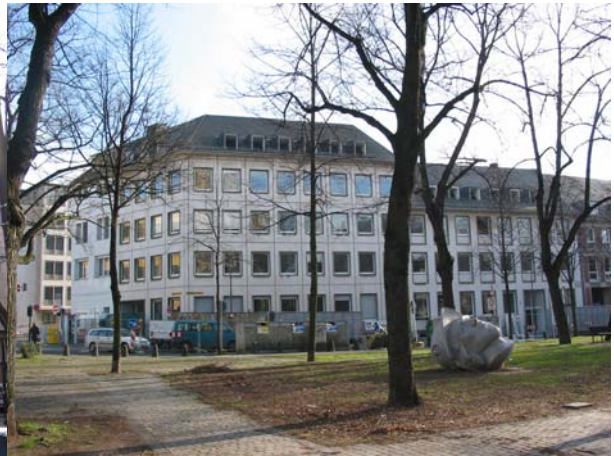
Bild 2: Gereonsdriesch, Altstadt Nord Abriss/ Neubau
