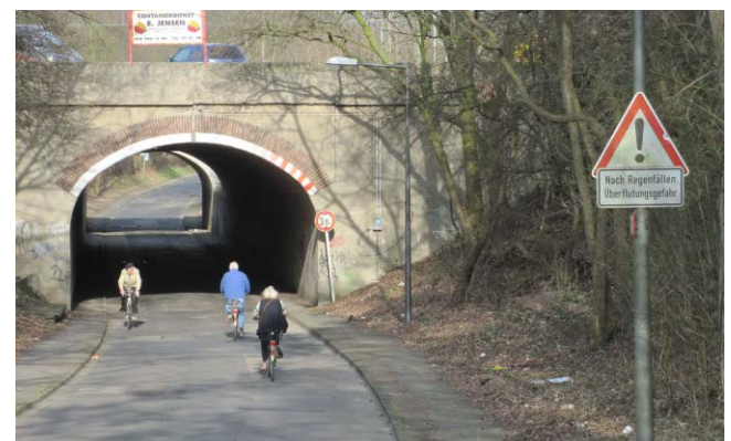
Bushaltestelle ‚Lindweilerfeld‘ und unattraktive Bahnunterführung Pingenweg
