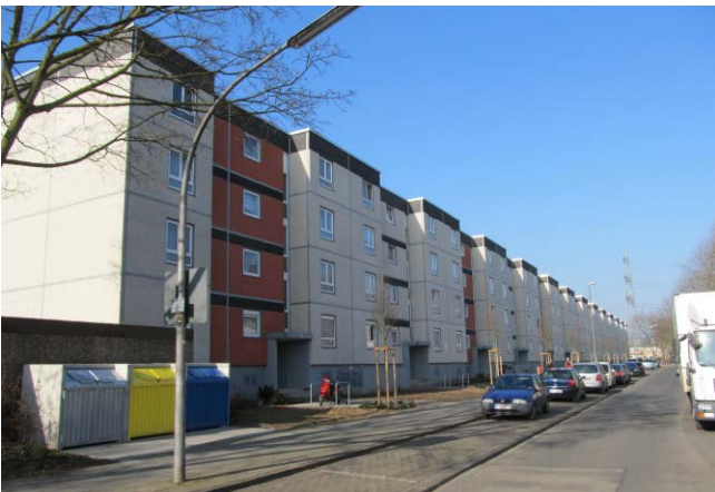
Wohnzeile am Stangenroder Weg (Vorder- und Rückansicht) nach der Modernisierung
